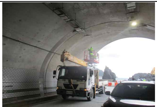
작업차를 이용한 근접조사
