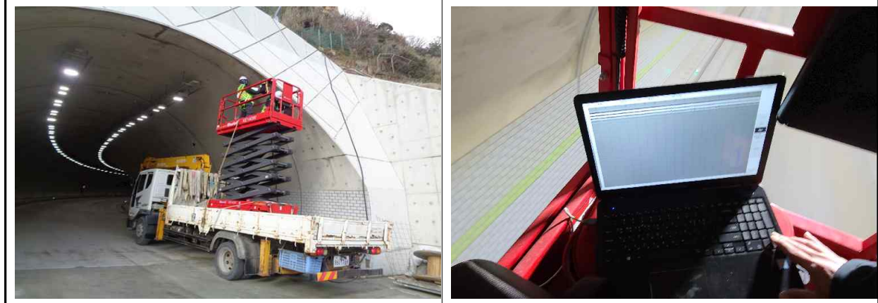
【그림 4.1-2】 자료취득 장비 제원 및 측정 장면
